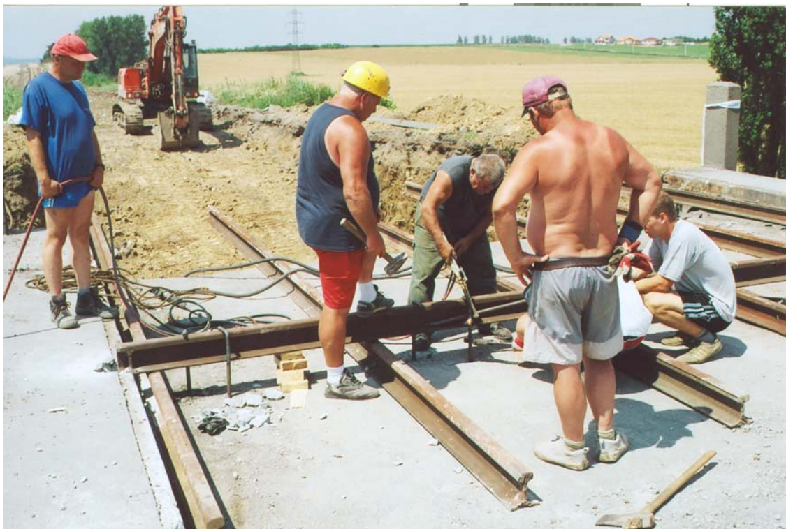
A konzolok szerelése
